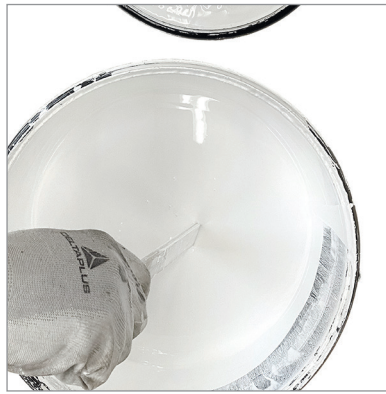
02 Ретельно перемішайте фарбу перед початком нанесенням
